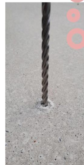
Forez la pyrite à l'aide d'une carotteuse, dia - 10-15 mm
