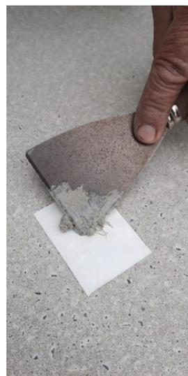
Préparez du mastic de réparation (pas trop coulant !) ; remplissez le trou foré au moyen de celui-ci
